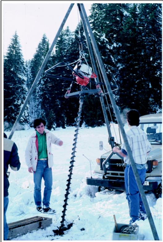
Figure 2.15. : Tarière à moteur Stihl du GEO-LEP sur véhicule tout-terrain. Sondage dans les sédiments palustres du glissement de terrain du marais de la Vraconne (Jura vaudois).
